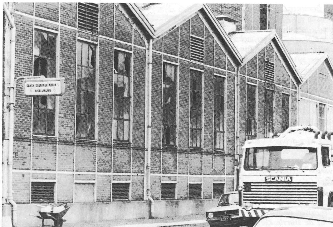
Kloranlægget tog skade ved eksplosionen.
