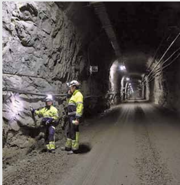
Ved atomkraftværket Olkiluoto i Finland begyndte man i 2004 at bygge verdens første slutlager til højradioaktivt affald, Onkalo, der går 500 m under jorden ned i granitfeltet
