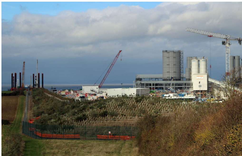
Konstruktion af Hinkley Point C i Storbritannien. Værket er forsinket og meget dyrere end budgetteret. Foto: Wikimedia Commons
